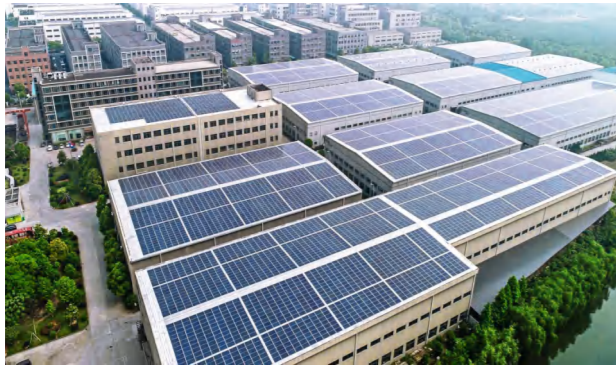
装机容量：6MWp 项目地点：浙江杭州 产品类型：帷幄BIPV屋顶系统
