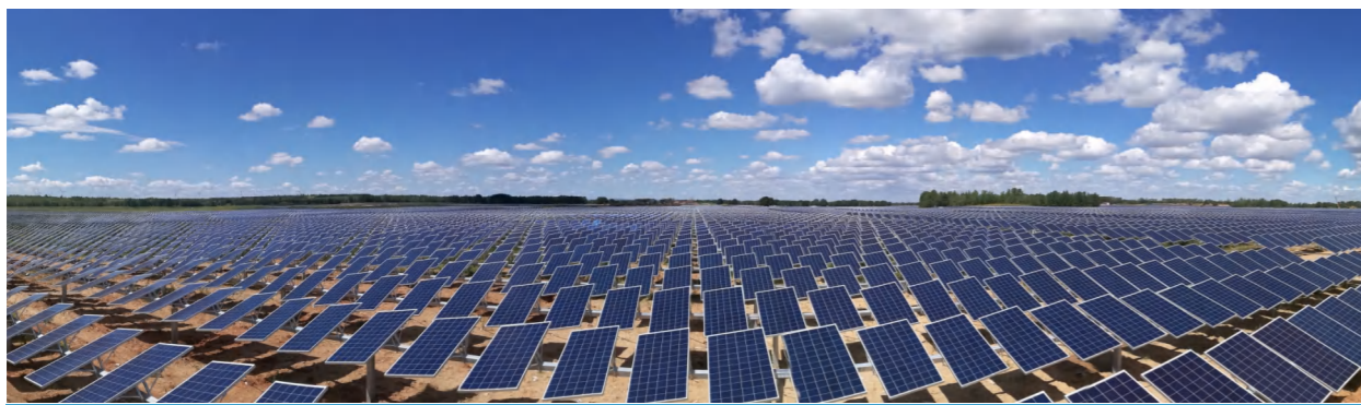
装机容量：50MWp 项目地点：河北张家口 产品类型：帷联跟踪系统
