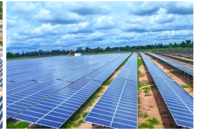
装机容量：60MWp 项目地点：泰国 产品类型：地面固定式光伏支架系统
