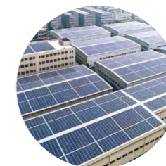
光电建筑 支架系统
