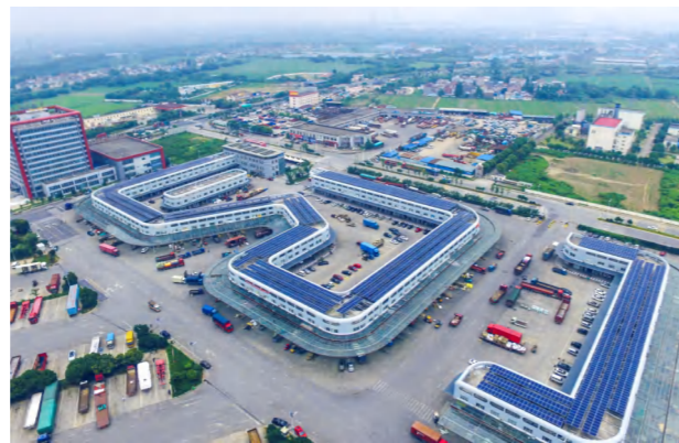
装机容量：10.8MWp 项目地点：浙江长兴 产品类型：帷幄BIPV屋顶系统
