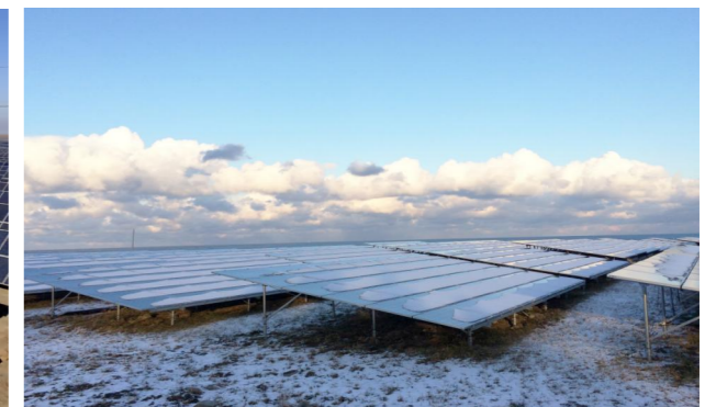
装机容量：12MWp 项目地点：日本 产品类型：地面固定式光伏支架系统
