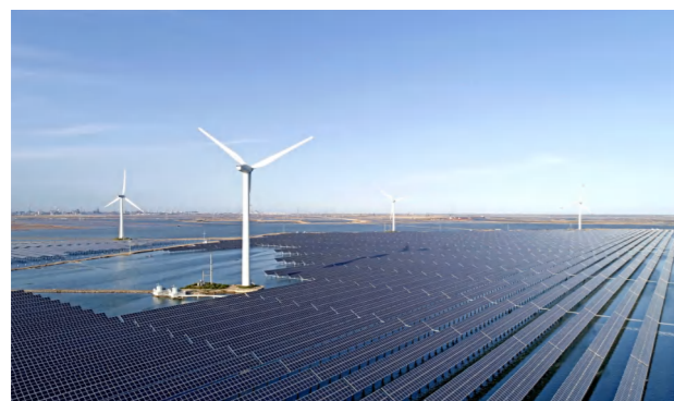
装机容量：258MWp 项目地点：河北海兴 产品类型：帷联跟踪系统
