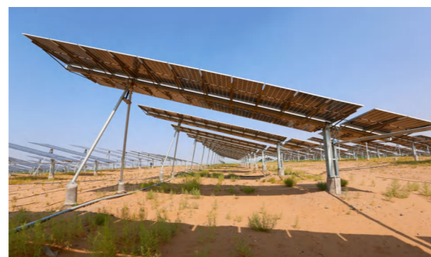
装机容量：115MWp 项目地点：内蒙古达拉特旗 产品类型：斜单轴跟踪系统
