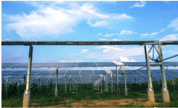
装机容量：3MWp 项目地点：河南南阳 产品类型：帷联跟踪系统
