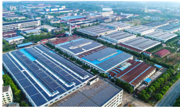
装机容量：20MWp 项目地点：浙江龙游 产品类型：帷幄BIPV屋顶系统
