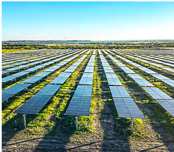
装机容量：200MWp 项目地点：美国德州 产品类型：帷联跟踪系统
