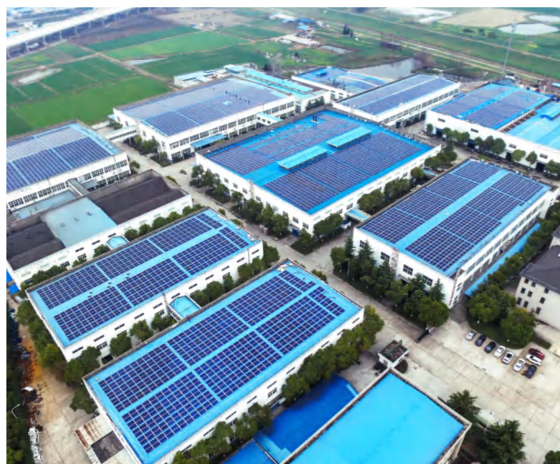
装机容量：5.5MWp 项目地点：江苏丹阳 产品类型：彩钢瓦屋顶系统
