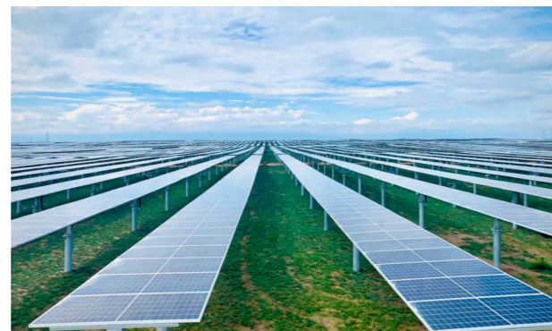
装机容量：460MWp 项目地点：青海共和 产品类型：帷屹跟踪系统
